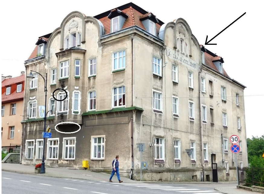
Fot.1. Widok budynku od strony pn-wsch. Okręgami oznaczono gniazda oknówki, strzałką miejsce prawdopodobnego gniazdowania kawki (aut. Szymon Wójcik).
