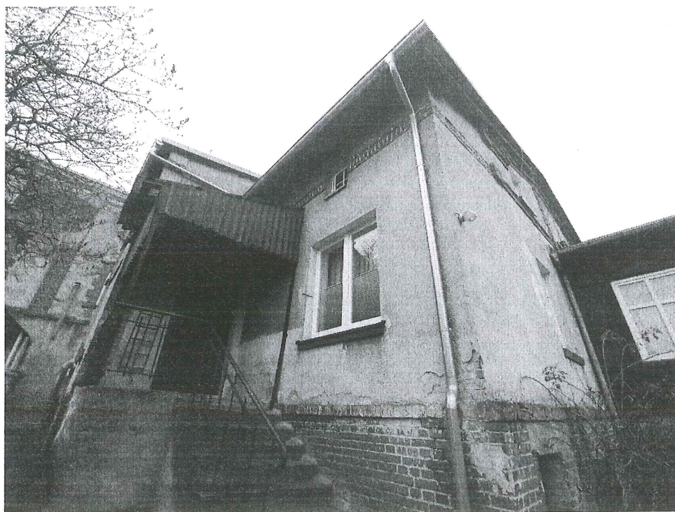
Fot.8. Widok budynku od strony zachodniej (aut. Szymon Wójcik).
