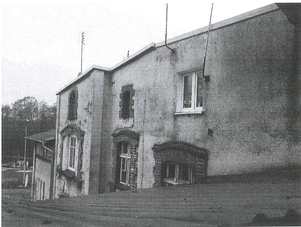
Fot.3. Widok ściany od strony południowej (aut. Szymon Wójcik).
