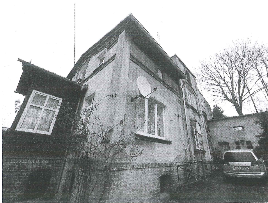
Fot.2. Widok budynku od strony pd-zach (aut. Szymon Wójcik).
