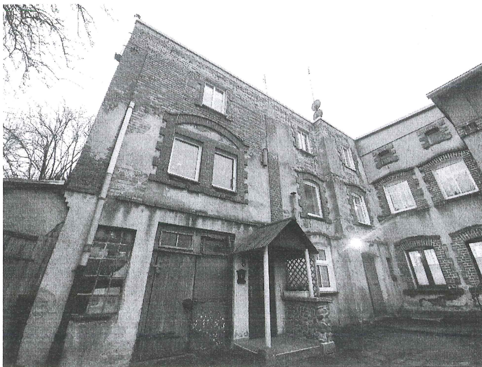
Fot.6. Widok budynku od strony zachodniej (aut. Szymon Wójcik).
