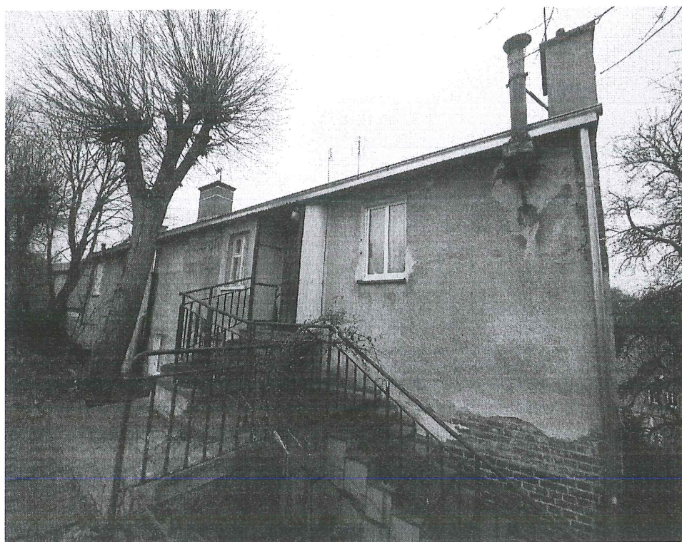
Fot.4. Widok budynku od strony wschodniej (aut. Szymon Wójcik).
