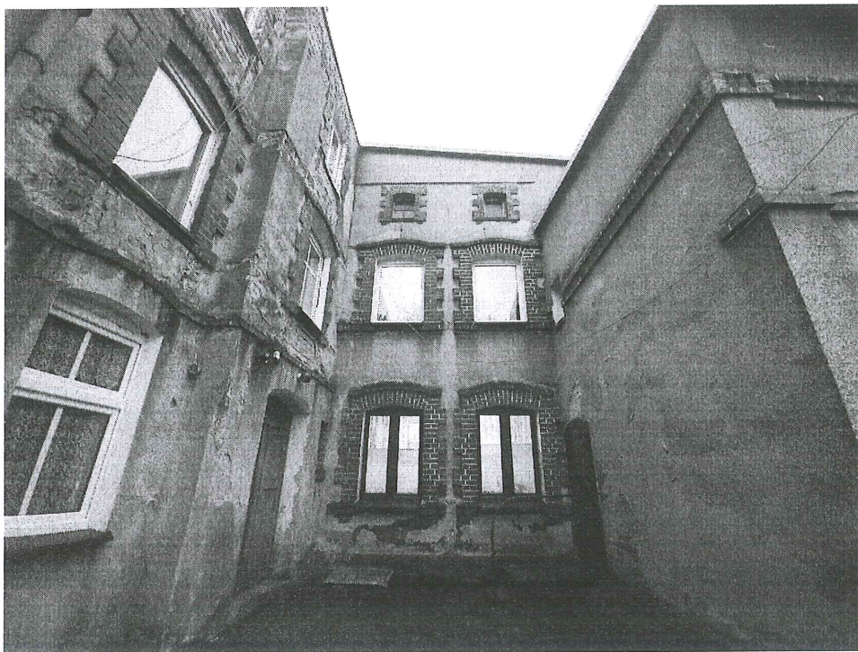
Fot.7. Widok budynku od strony zachodniej (aut. Szymon Wójcik).
