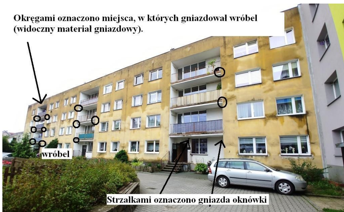
Fot.5. Miejsca gniazdowania ptaków na ścianie północnej, napisem miejsce w którym odnotowano gniazdowanie wróbla (aut. Szymon Wójcik).
