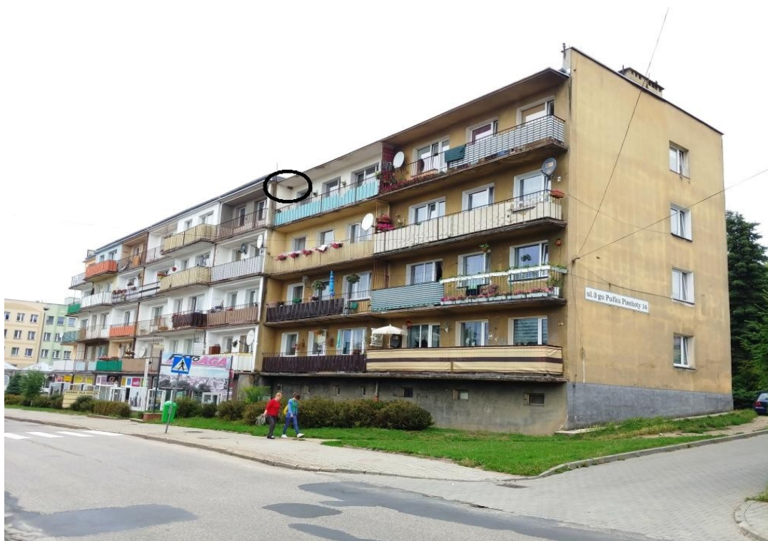
Fot.3. Widok budynku od strony pd-wsch. Oznaczono 2 gniazda oknówki (aut. Szymon Wójcik).
