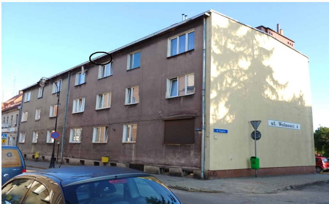
Fot.2. Widok budynku od strony pd-wsch. Oznaczono gniazda oknówki z poprzednich sezonów; obecnie niezasiedlone w 2018 r. (aut. Szymon Wójcik).
