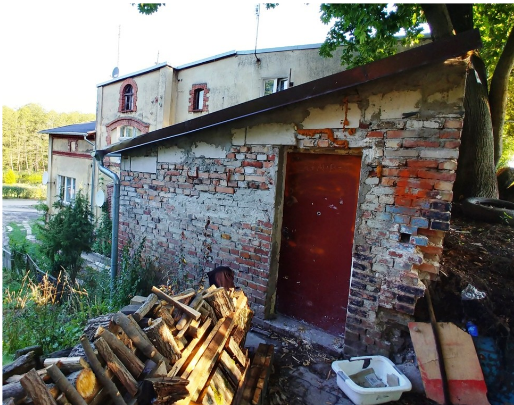
Fot.5. Widok budynku od strony południowej (aut. Szymon Wójcik).
