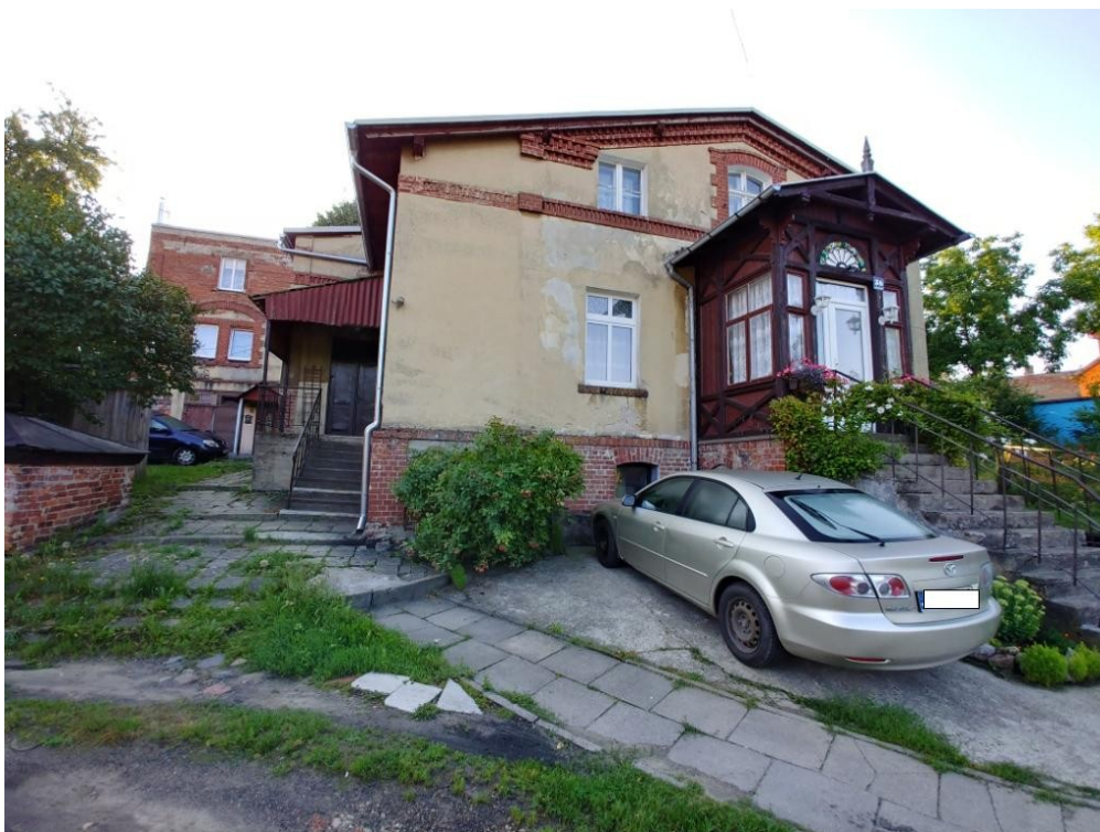
Fot.2. Widok budynku od strony pn-zach (aut. Szymon Wójcik).
