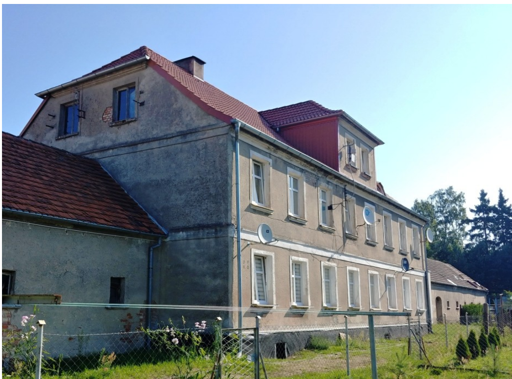
Fot.4. Widok budynku od strony pd-zach (aut. Szymon Wójcik).
