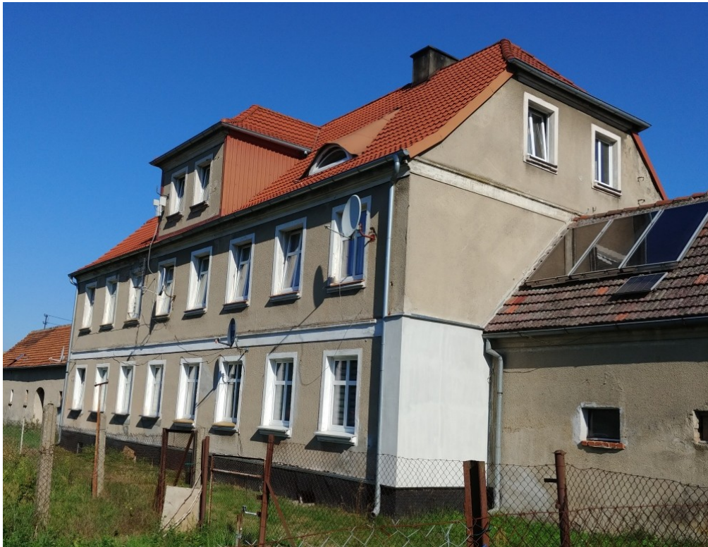
Fot.3. Widok budynku od strony pd-wsch (aut. Szymon Wójcik).
