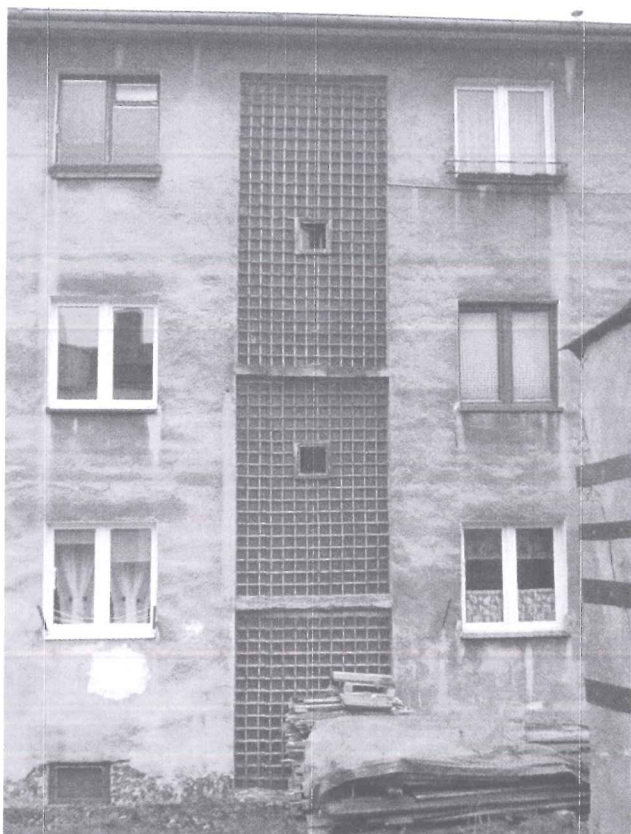
Klatka schodowa z naświetlami z luksferów
