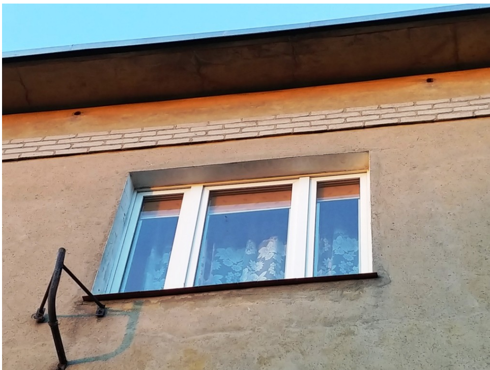
Fot.5. Wygląd otworów wlotowych do stropodachu (aut. Szymon Wójcik).
