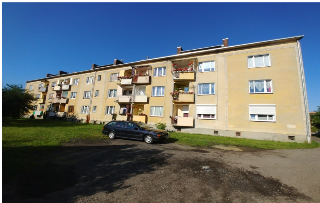
Fot.2. Widok budynku od strony wschodniej. Ptaki gniazdują w stropodachu (aut. Szymon Wójcik).
