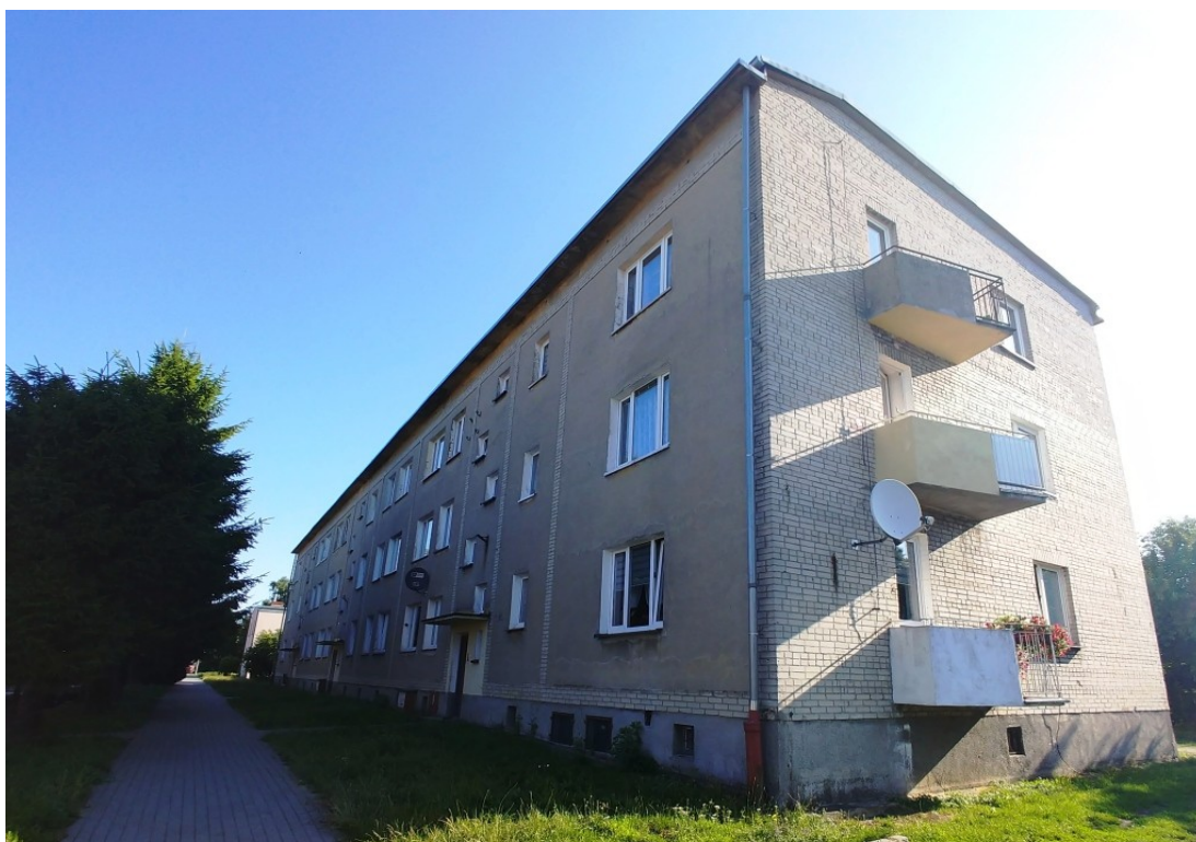
Fot.1. Widok budynku od strony pd-zach. Ptaki gniazdują w stropodachu, do którego dostają się przez wloty (aut. Szymon Wójcik).
