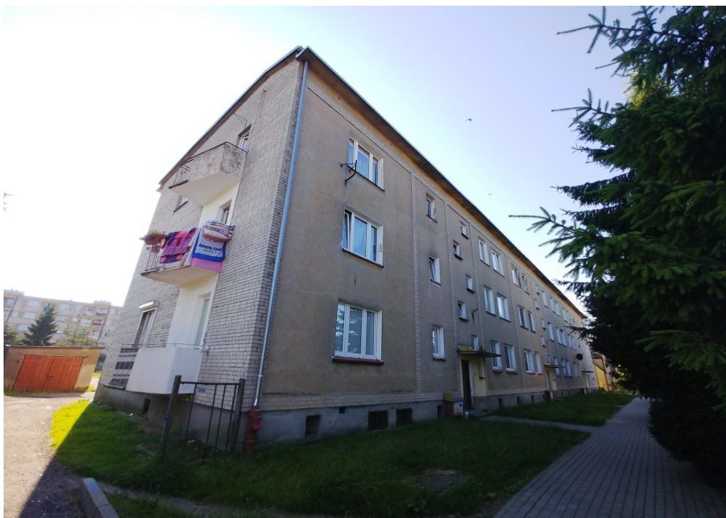
Fot.4. Widok budynku od strony pn-zach. Ptaki gniazdują w stropodachu (aut. Szymon Wójcik).
