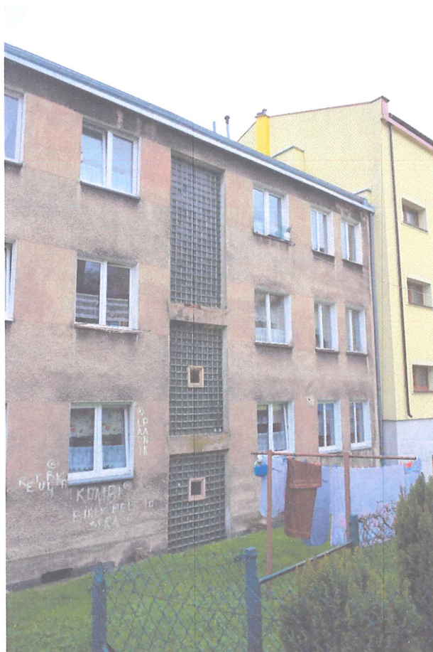
Klatka schodowa z naświetlami z luksferów
