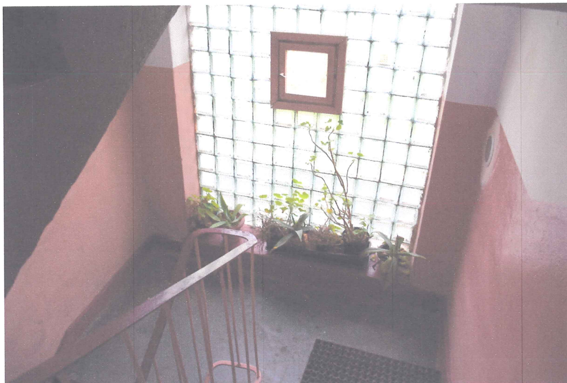
Naświetla od strony wewnętrznej z zamontowanym oknem.
