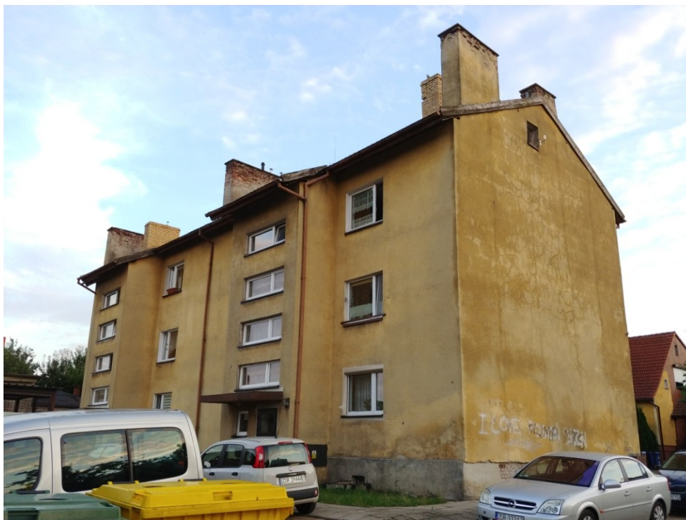
Fot.3. Widok budynku od strony pn-wsch (aut. Szymon Wójcik).
