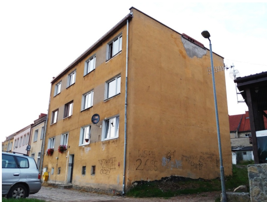
Fot.1. Widok budynku od strony pd-wsch (aut. Szymon Wójcik).
