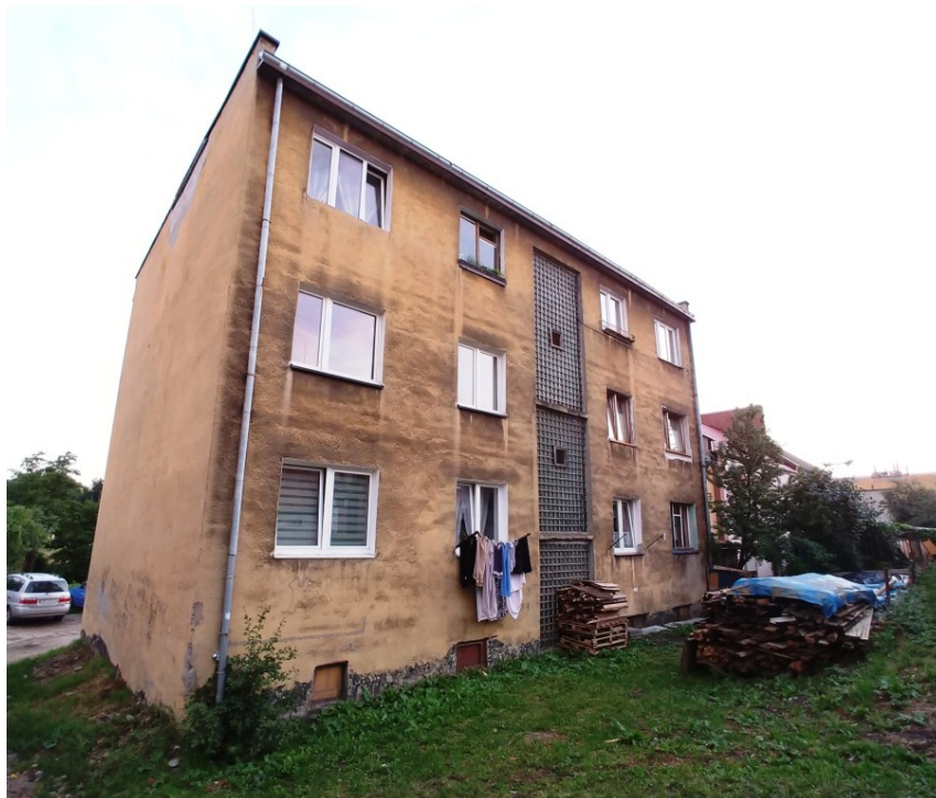
Fot.2. Widok budynku od strony pn-wsch (aut. Szymon Wójcik).
